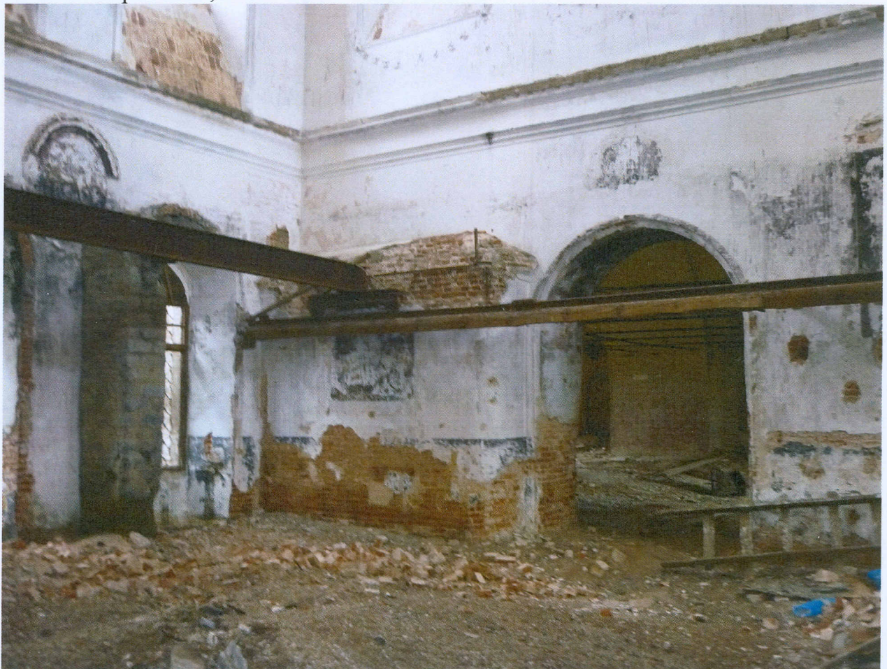
Фото № 7. Помещения объекта культурного наследия. Холодный храм. Фото: И.С. Бережных, 08.07.2016.
