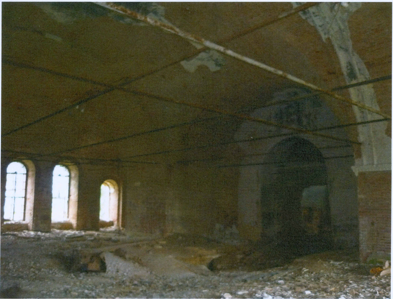
Фото № 6. Помещения объекта культурного наследия. Трапезная. Фото: И.С. Бережных, 08.07.2016.
