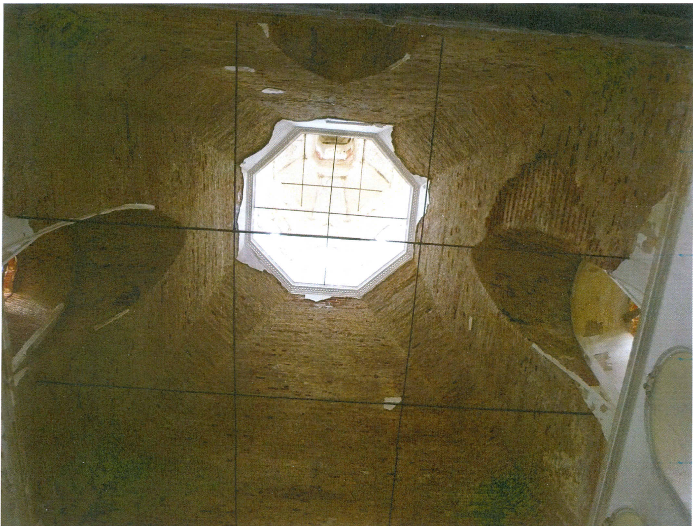
Фото № 7. Помещения объекта культурного наследия. Купол холодного храма. Фото: И.С. Бережных, 08.07.2016.
